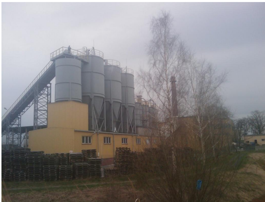
Baniaki stojące na tyłach Huty, służą do mieszania trzech składników plus
